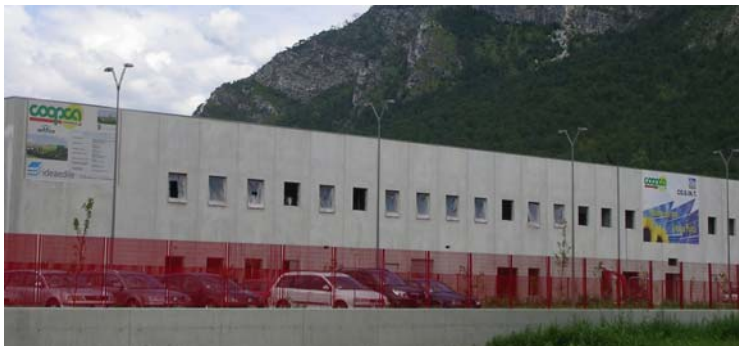
Figura 41 capannone con tetto a pannelli fotovoltaici
