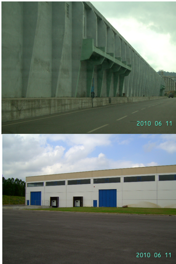
Figura 13 - capannoni ristrutturati e nuovi
