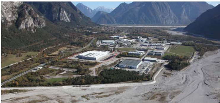
Figura 40 intervento difesa spondale fiume Tagliamento
