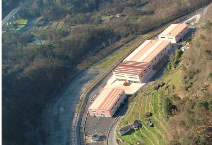
Figura 21 - area stoccaggio rifiuti e bacino raccolta acque
