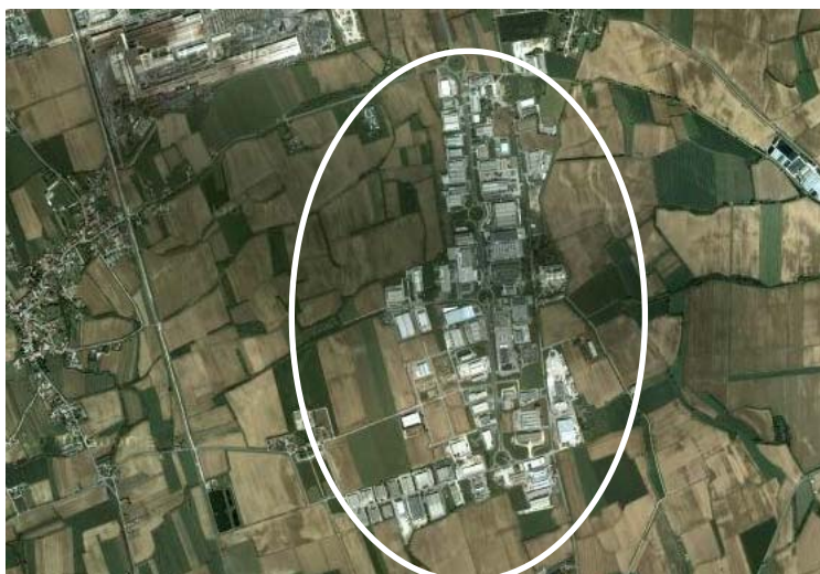
Figura 33 foto panoramica dell'area
