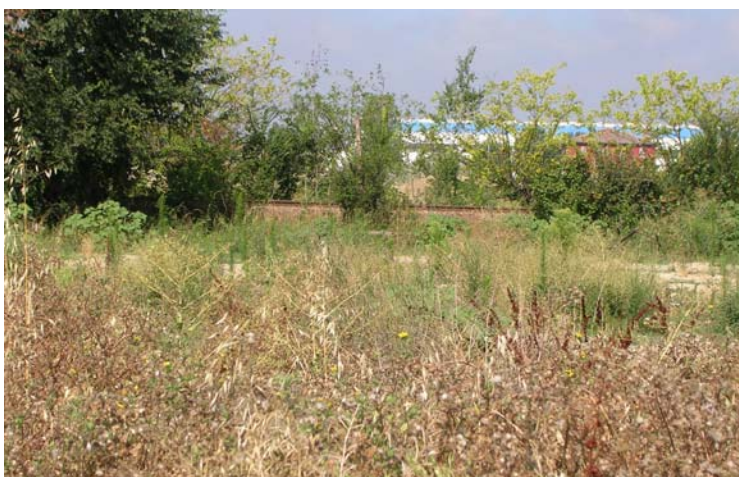
Figura 5 rilevato ferroviario dismesso
