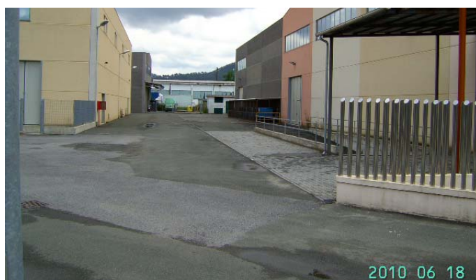
Figura 23 - accesso all'area produttiva
