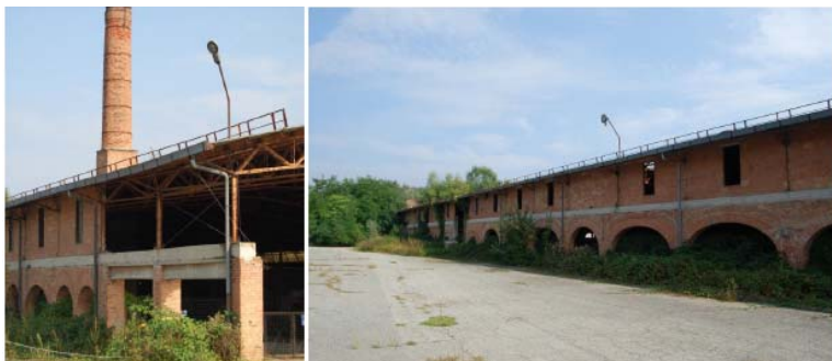
Figura 48 - Fornace esistente e capannoni
