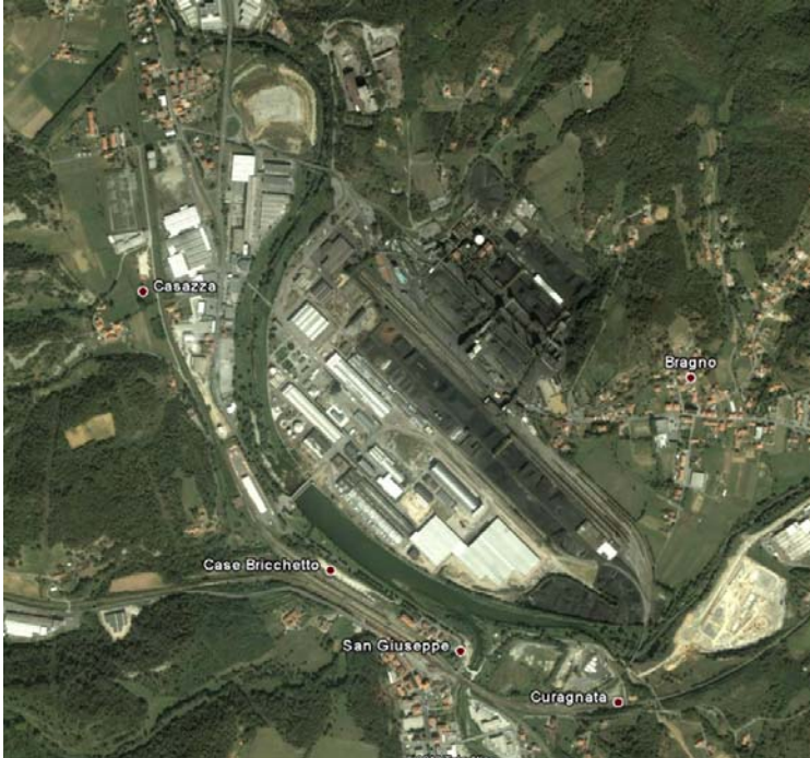
Figura 12 - foto area dell'ambito produttivo
