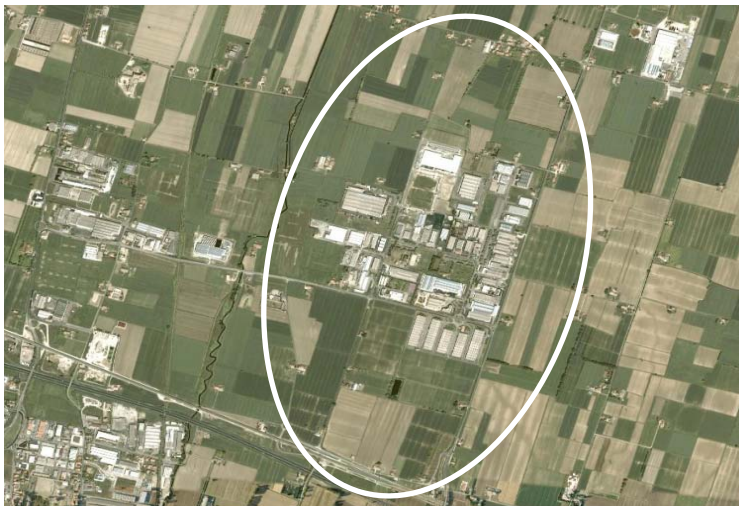
Figura 1 foto panoramica dell'area industriale
